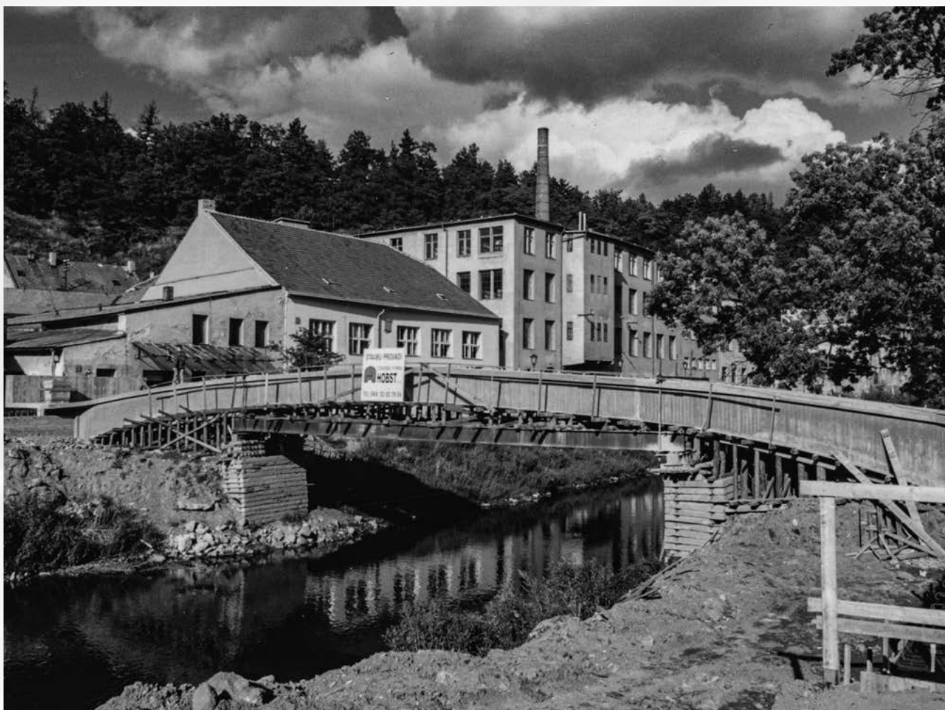
↑ Dokončovací práce na lávce pro pěší (1996).
